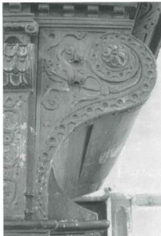
Fig. 4.- Console assurant la transition entre le soubassement et l'étage réservé aux tuyaux. Photo J.-P. Félix, 1999.
